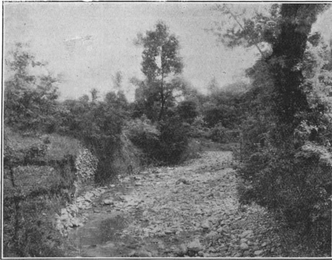
FIG. II.—SITE OF THE PONTE S. MARCO.
